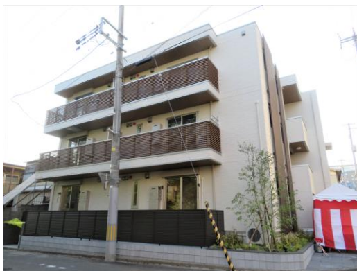
事例② 仙台市若林区新寺 3階建てアパート
